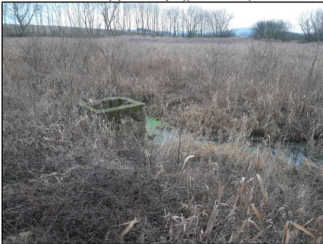
Foto - Podhrázský rybník a stávající výpustné zařízení - požerák
