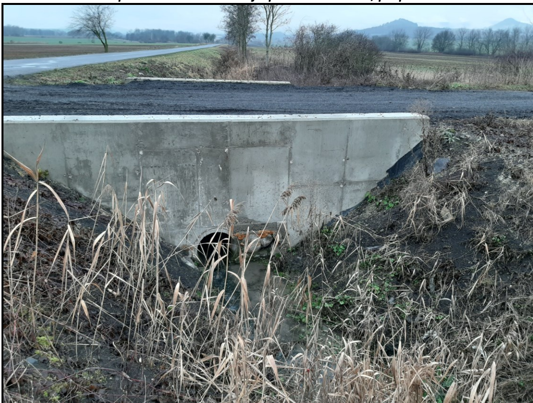
Foto – Hlavní přítok Rosovka - vedlejší polní cesta – VC2, propustek P7 DN600
