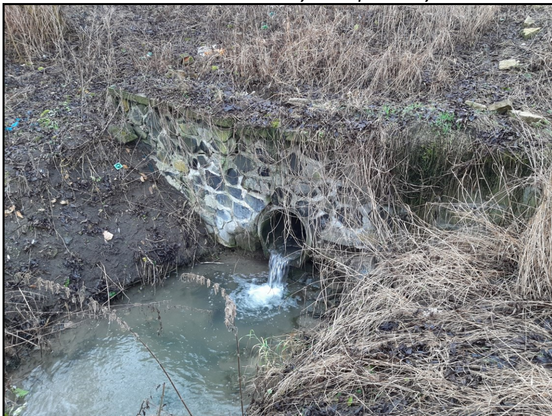
Foto - Zborcené kamenné čelo u vyústění z požeráku rybníka
